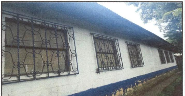
Foto 4: Sustitución de Ventanas por metal mas vidrio, planta baja.
